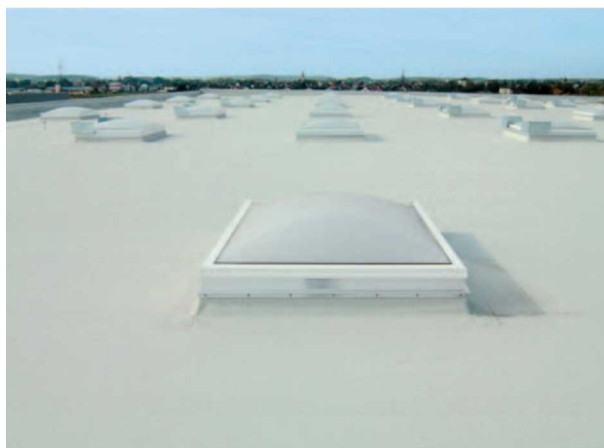
Systemowy dach płaski Schedetal w Norymberdze.
